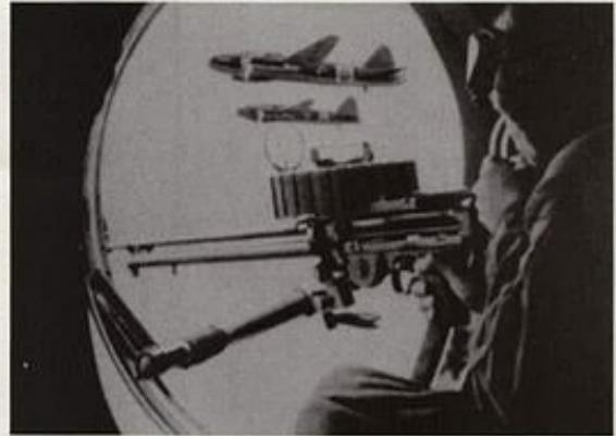
**UNA DE CUATRO** El G4M tenía cuatro puestos de ametralladoras, todas tipo 92 calibre 7,70. Una en el morro, dos en los flancos y una dorsal, más un cañón de 20 mm en la cola.
